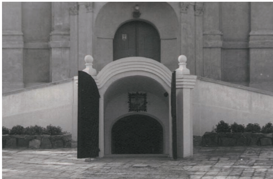
Wejście do piwnic kościoła od strony ściany frontowej
